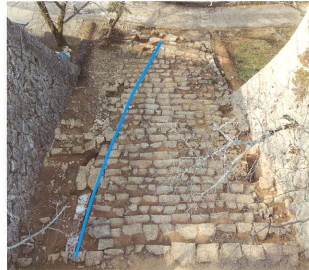
写真7 調査区4、5全景 (東から) 青線部分が豊島石製排水溝の北側面。
