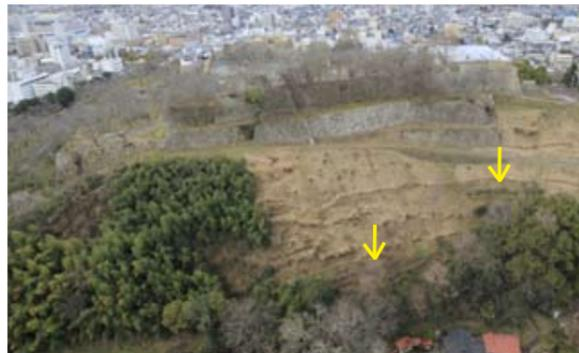
写真20 二の丸東側石垣と落石防止柵(矢印部分にフェンス)
