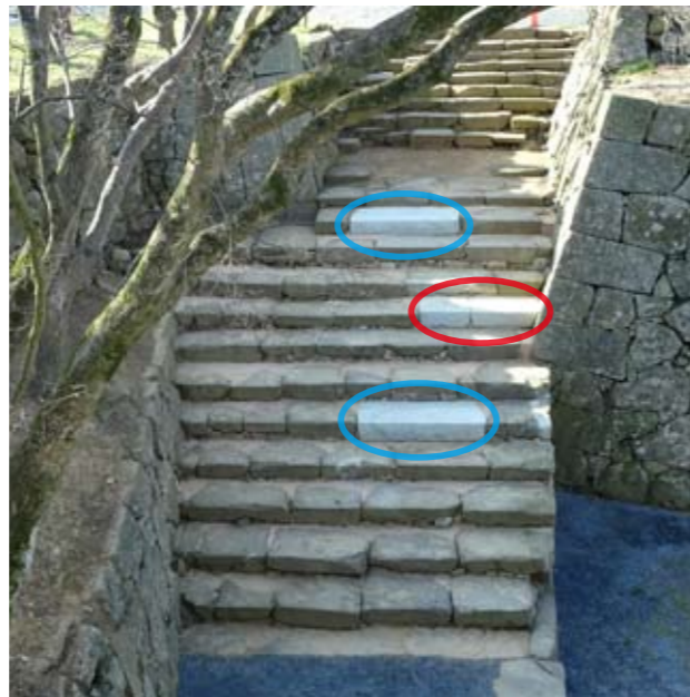
写真15 整備後（北から） 青丸は交換した石、赤丸は補填した石です。
