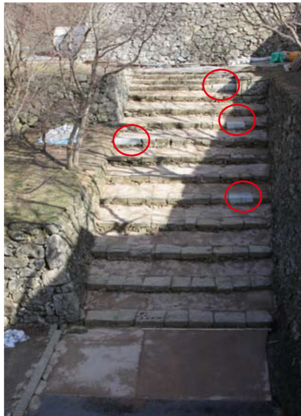
写真4 雁木の石を復旧。雁木間は遺構保護のため土系舗装
