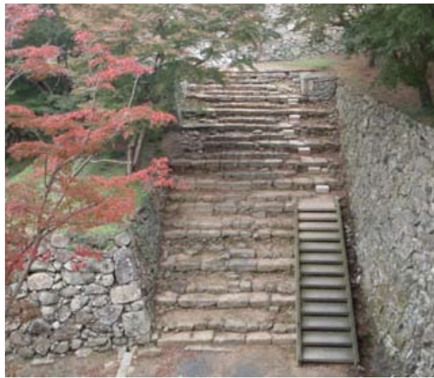
写真2 整備前の裏鉄門下雁木
