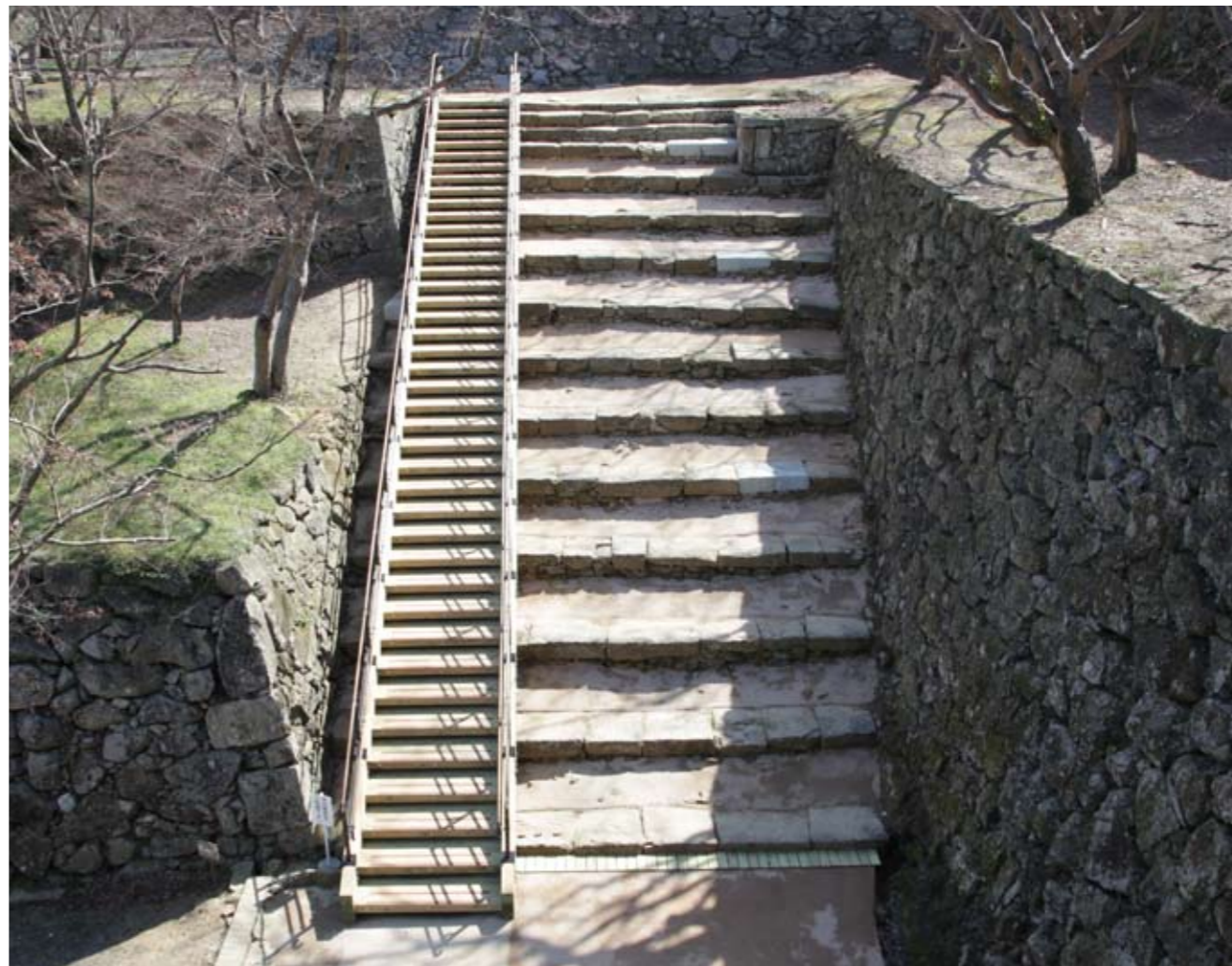
写真1 裏鉄門下雁木と新しく取り付けられた木製階段(西から)
