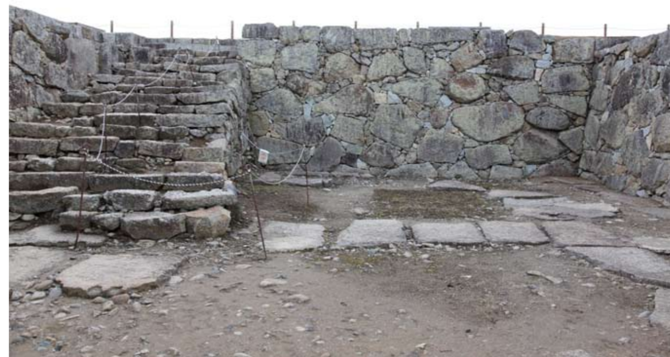
写真2 間詰め石補修完了後
