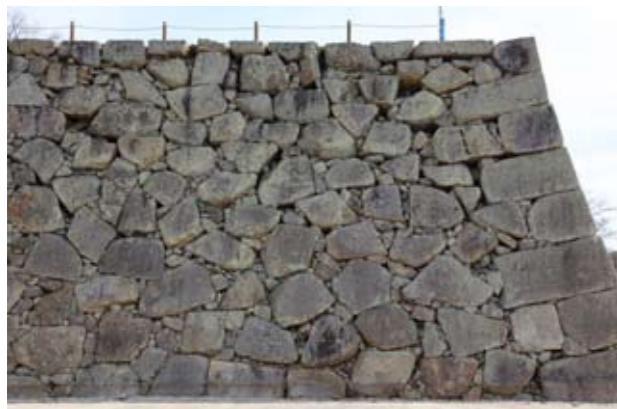
写真5 ②のタイプの石垣（天守台西面石垣）
