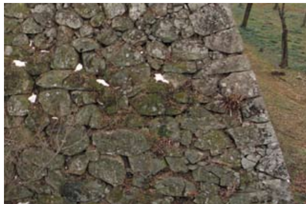
写真4 ①のタイプの石垣（月見櫓北面石垣）
