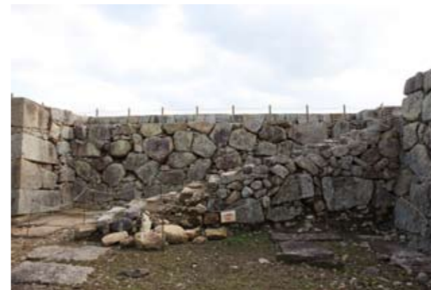
写真7 南面（写真3の1）（補修前）
