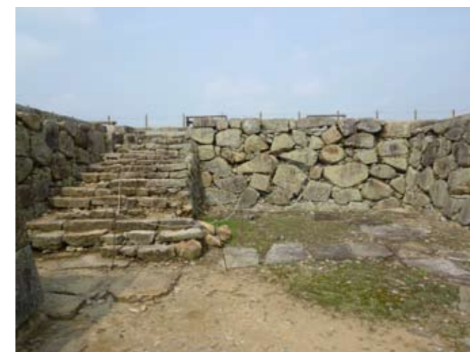
写真1 間詰め石を詰める前（穴蔵西面石垣）
