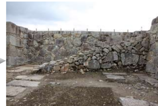
写真8 補修後
