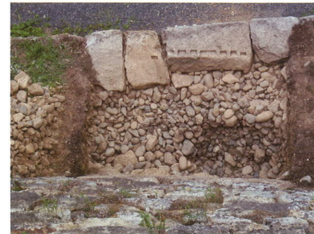
写真6 トレンチ2 栗石検出状況(左が北)
