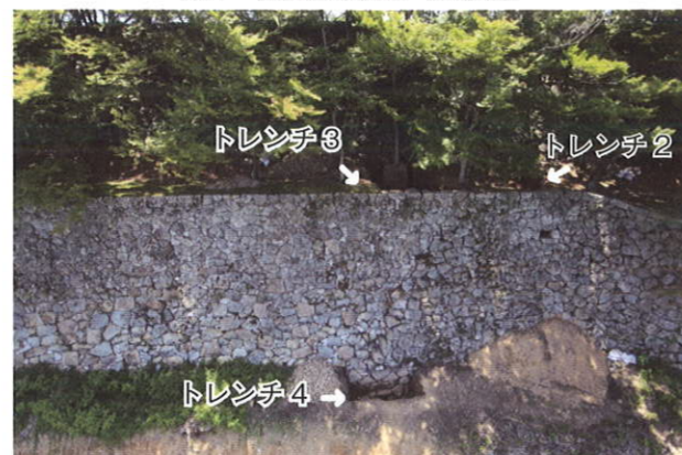
写真6 東側法面石垣とトレンチの位置
