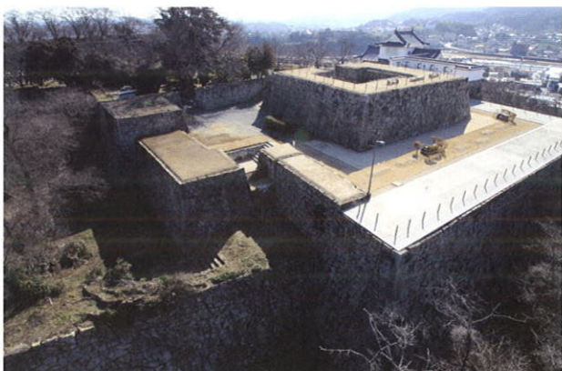
写真1 整備を完了した七番門虎口(北西から)
