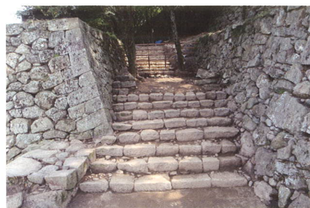
写真8 トレンチ1北側の雁木(北から)
