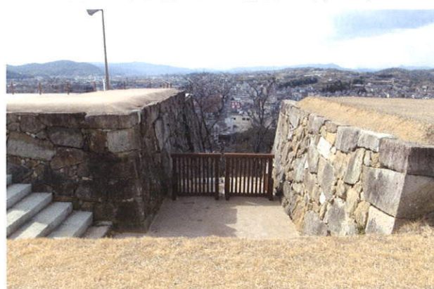
写真5 整備後の七番門虎口
