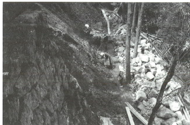
写真16 昭和40・41年の修復工事(その2)
