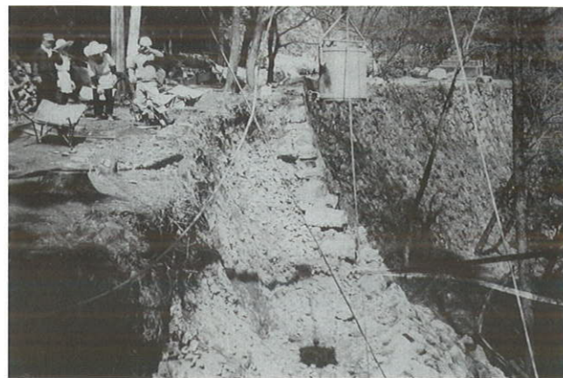
写真15 昭和40・41年の修復工事(その1)
