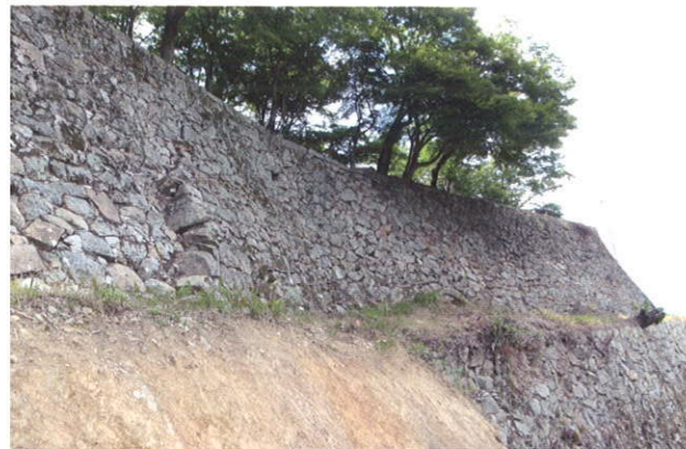
写真14 現在の東側法面石垣
