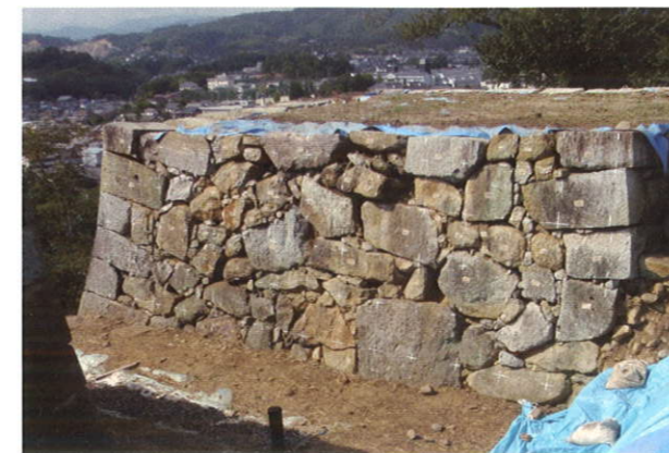
写真6 七番門跡北面石垣整備前(南から)
