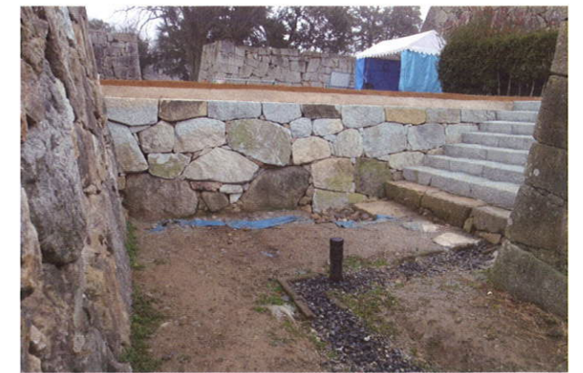
写真5 七番門跡整備後(西から)
