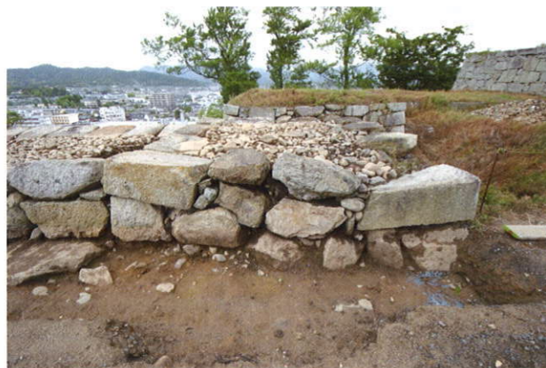
修理前（七番門櫓台）
