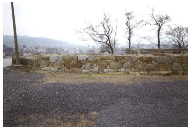
修理後（北面多門櫓部分）
