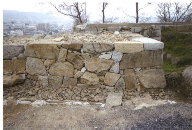
修理後（七番門櫓台）
