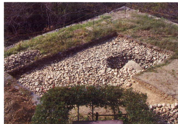
発掘調査により現れた多門櫓部分の栗石
