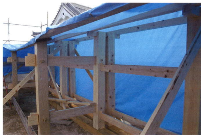
復元途中の土塀の柱の様子
