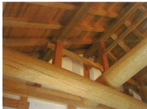
張出室天井の様子
