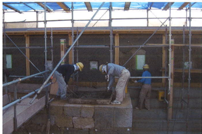
土塀の壁塗の様子
