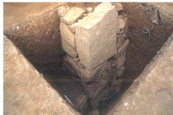
内側石垣南西隅部分
