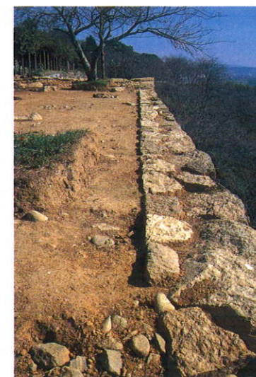
備中櫓南側基礎の状態（西から）
