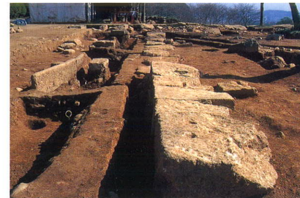
備中櫓北側基礎の状態（西から）
