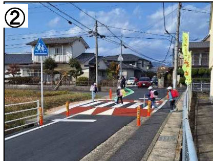
スムーズ横断歩道 (完成状況)
