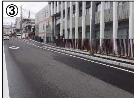
歩道拡幅 (完成状況)
