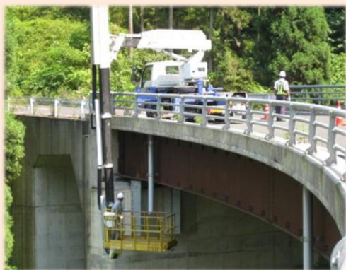
橋梁点検車による点検
