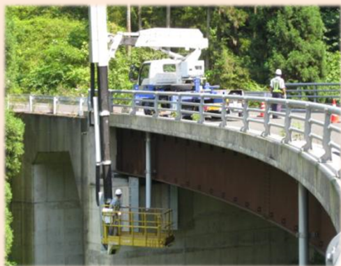
橋梁点検車による点検
