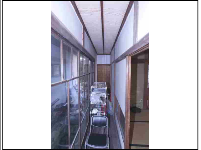
NO.62 内部・廊下1
