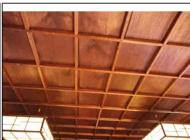
NO.36 内部・和室1
