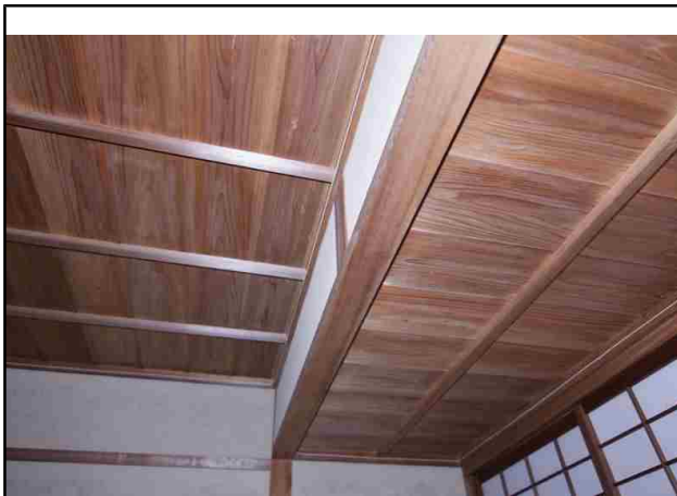
NO.93 内部・和室3
