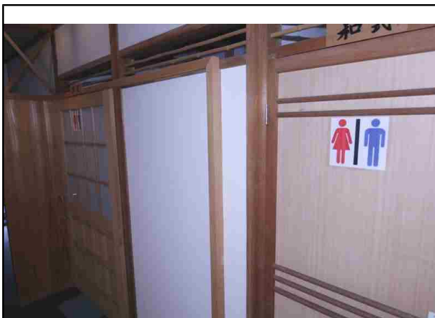
NO.15 内部・前室1
