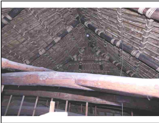
N0.1 小屋裏・収納3上部
