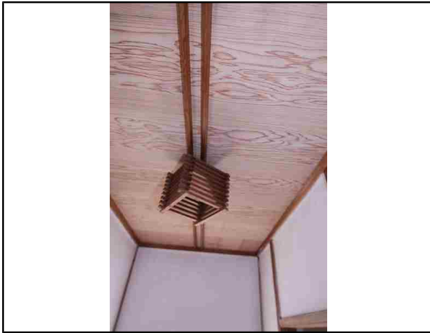
NO.21 内部・トイレ1
