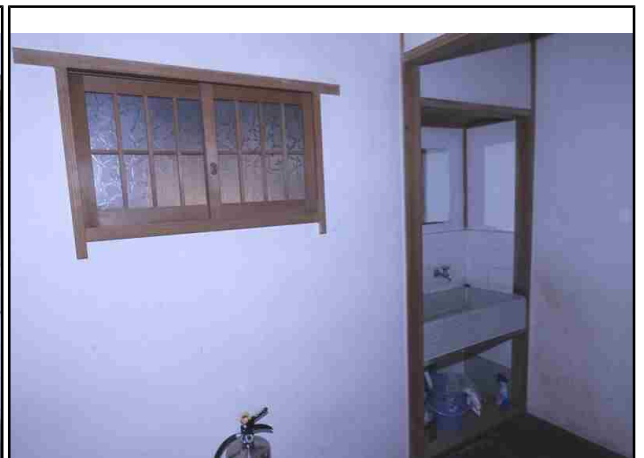
NO.12 内部・前室1
