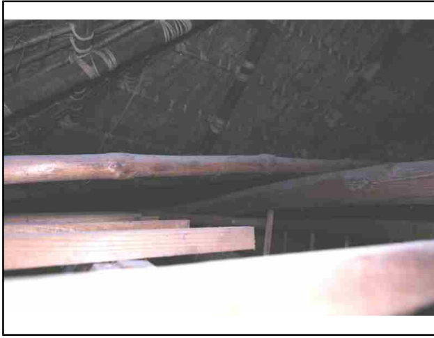
NO.7 小屋裏・収納3上部
