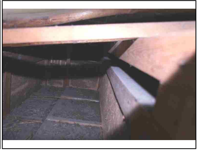
NO.8 小屋裏・収納3上部
