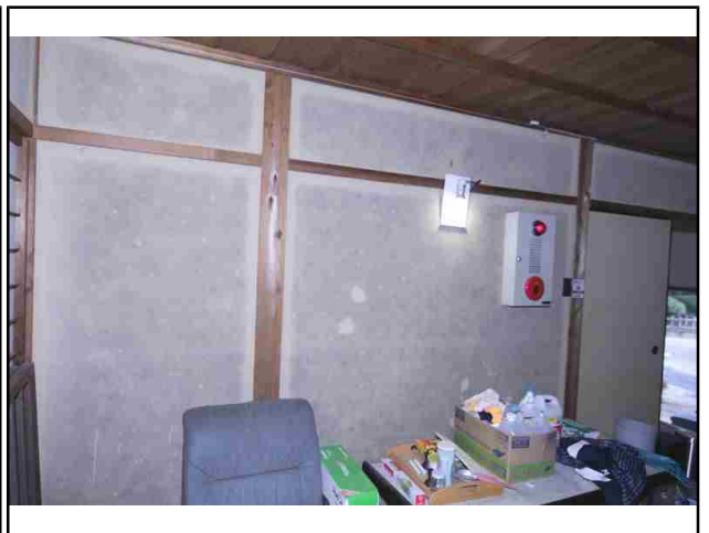
NO.84 内部・前室2
