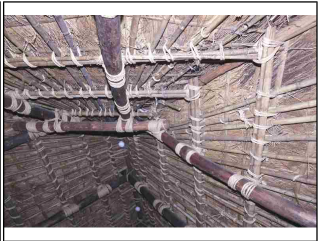
N0.2 小屋裏・収納3上部
