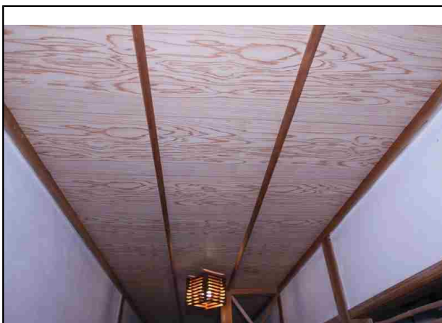
NO.17 内部・前室1
