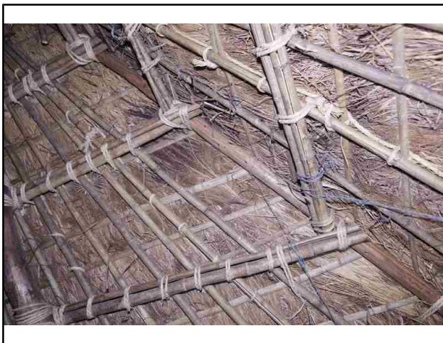
N0.5 小屋裏・収納3上部
