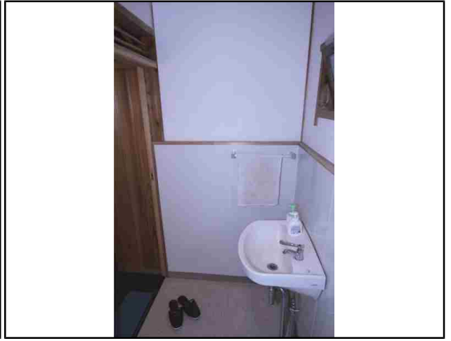
NO.26 内部・トイレ3
