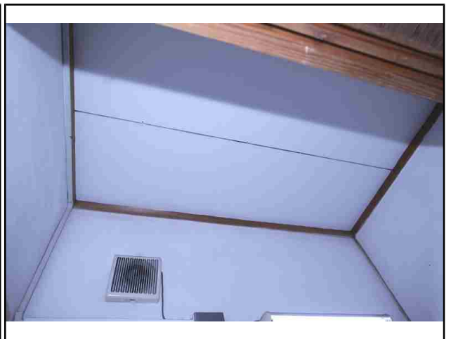
NO.30 内部・台所
