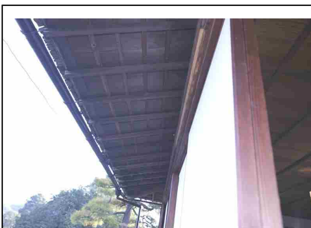
№65 外部・余芳館2階 軒裏（南側）
