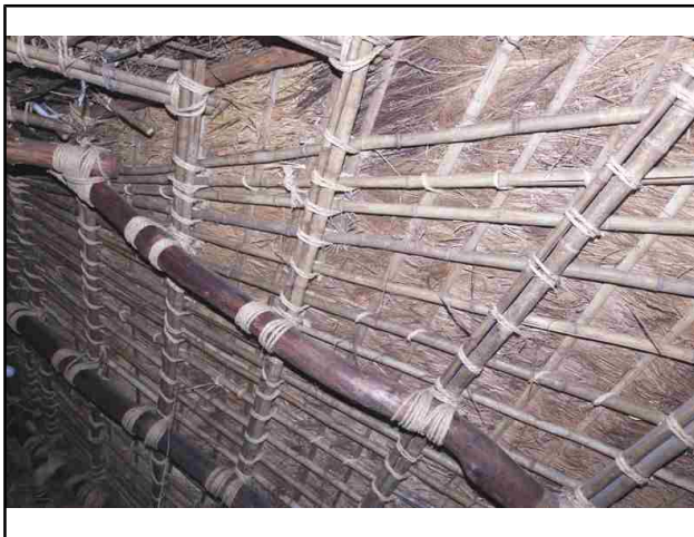
N0.3 小屋裏・収納3上部
