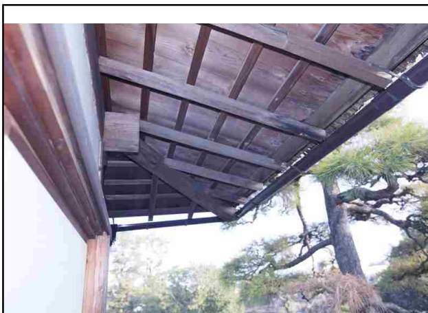
№63 外部・余芳館2階 軒裏（西側）
