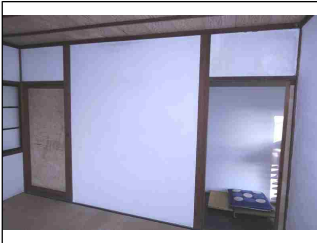
NO.51 内部・控室
