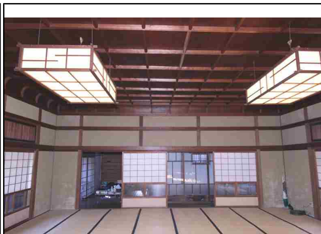
NO.34 内部・和室1
