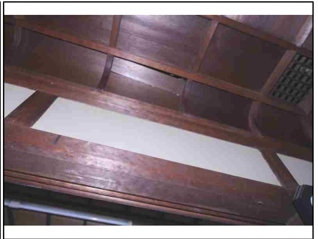
NO.38 内部・和室1
