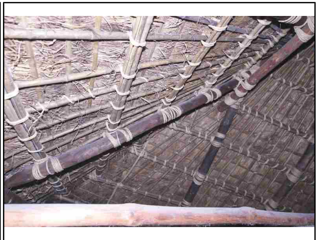
N0.4 小屋裏・収納3上部
