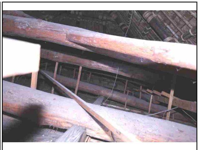
N0.6 小屋裏・収納3上部
