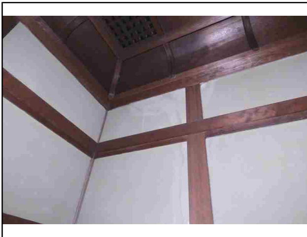
NO.39 内部・和室1
