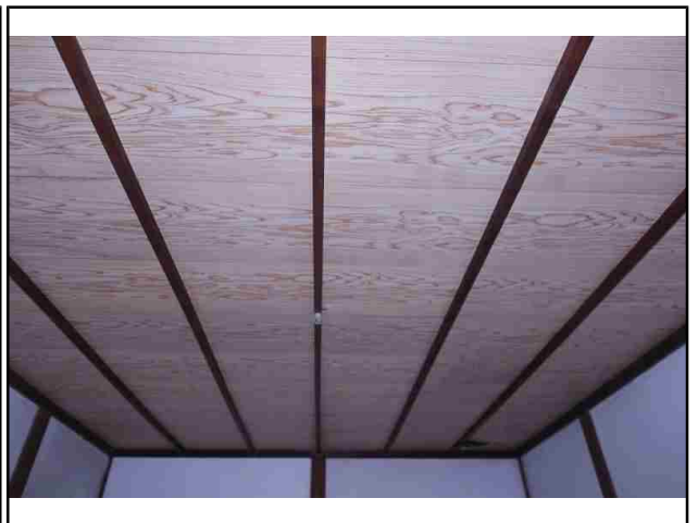
NO.54 内部・控室
