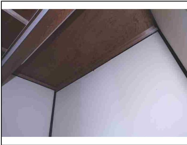
NO.79 内部・和室2
