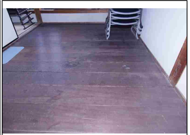
NO.110 内部・廊下2
