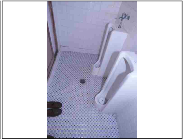
NO.22 内部・トイレ1
