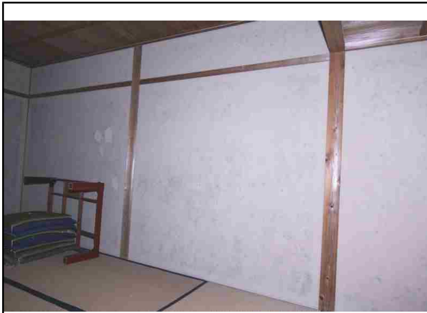
NO.91 内部・和室3
