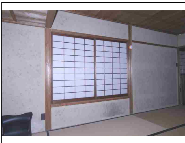
NO.89 内部・和室3
