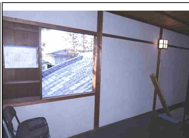
NO.108 内部・廊下2
