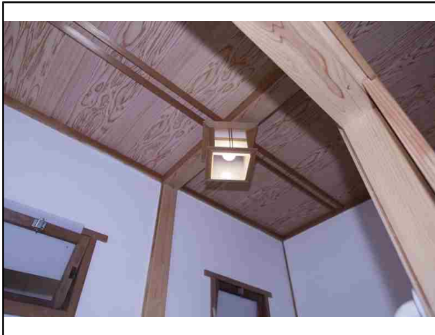
NO.27 内部・トイレ3
