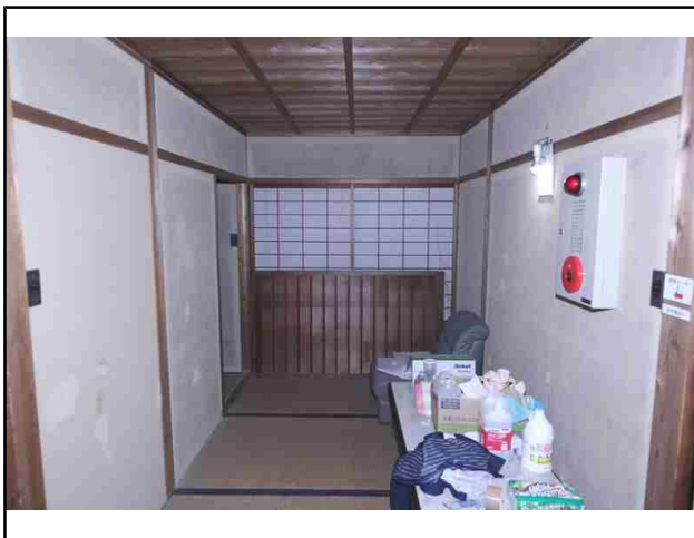
NO.83 内部・前室2
