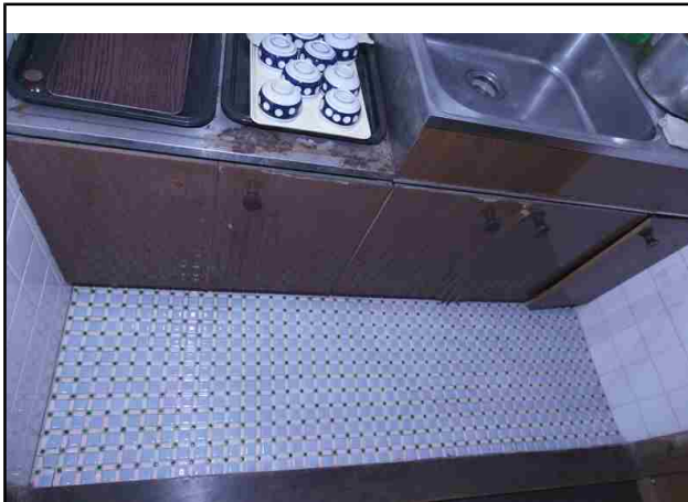
NO.31 内部・台所
