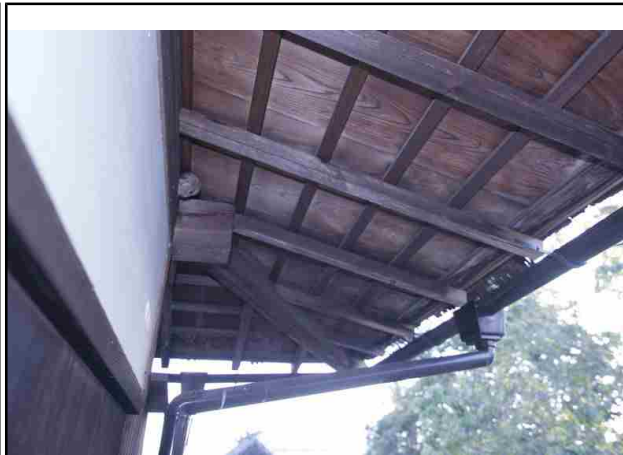
№62 外部・余芳館2階 軒裏（北側）
