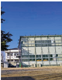
河辺小学校の仮設校舎
