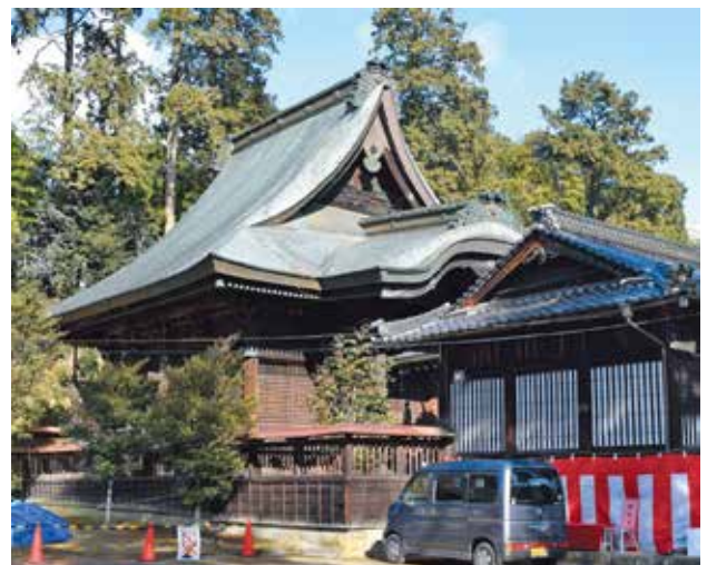
修理着工前の本殿 銅板葺きに改められている
