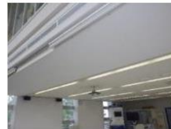
愛知工大防災研究センター
