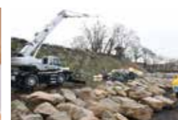
津山城跡整備
