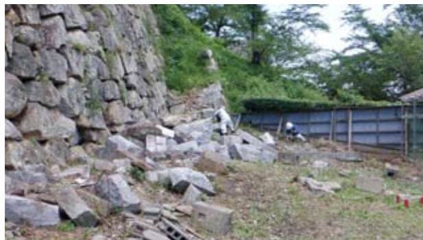
写真2 長柄櫓南側 石材等撤去前（南西から）
