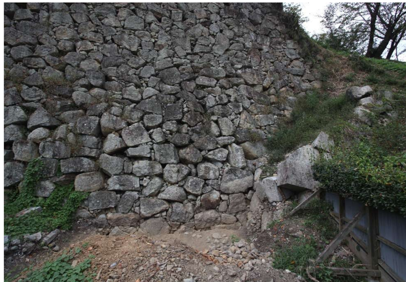
写真1 長柄櫓南面石垣（南から）
