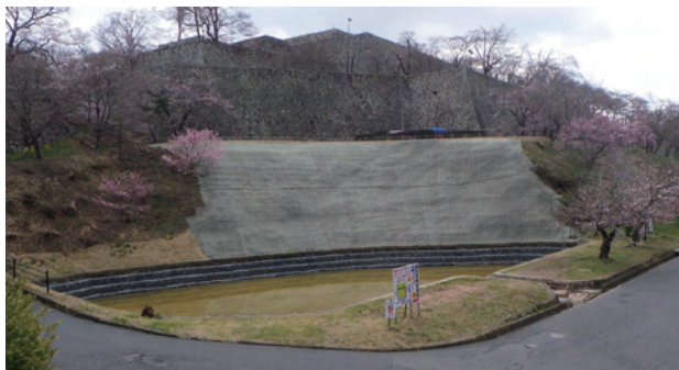
写真10 災害復旧工事完了後（北西から）
