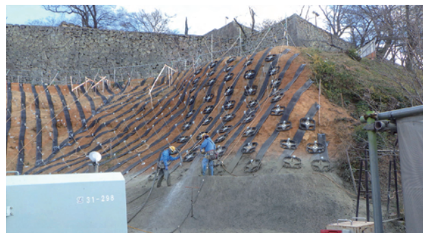
写真8 連続繊維補強土工（令和2年12月撮影）（西から）
