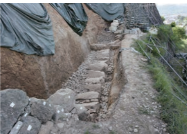
←写真7 排水溝の背面状況 解体の際確認された石垣内部の排水溝については、復旧の際も同様に積み直しを行いました。手前の大きな石が排水溝の蓋石です。
