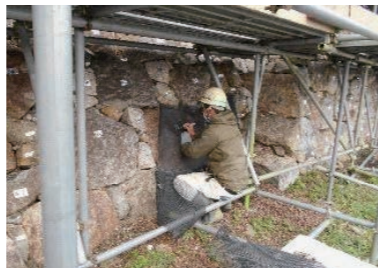
←写真5 埋没石垣 石垣の解体とともに背面を掘削していくと、埋没していた石垣が出現しました。
