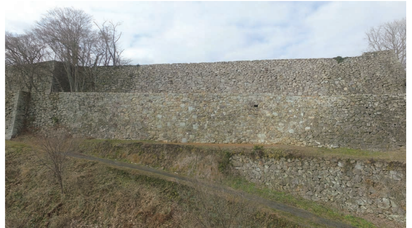
写真1 二の丸東側石垣（東からドローンで撮影）
