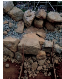
写真8 碎石を充填→ 復旧の際には、栗石（河原石）だけでは隙間ができ、栗石が内部で動く恐れがあるため、栗石の隙間に碎石を詰めました。
