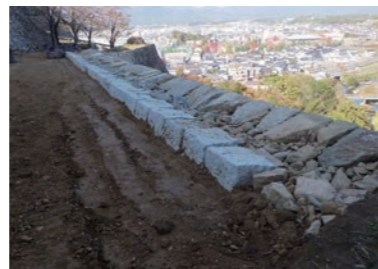
写真8 碎石を充填→ 復旧の際には、栗石（河原石）だけでは隙間ができ、栗石が内部で動く恐れがあるため、栗石の隙間に碎石を詰めました。
