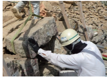
写真4 石の型取り→ 花崗岩の築石は凝灰岩に取り替えるため、同じ形になるよう型取りをしました。
