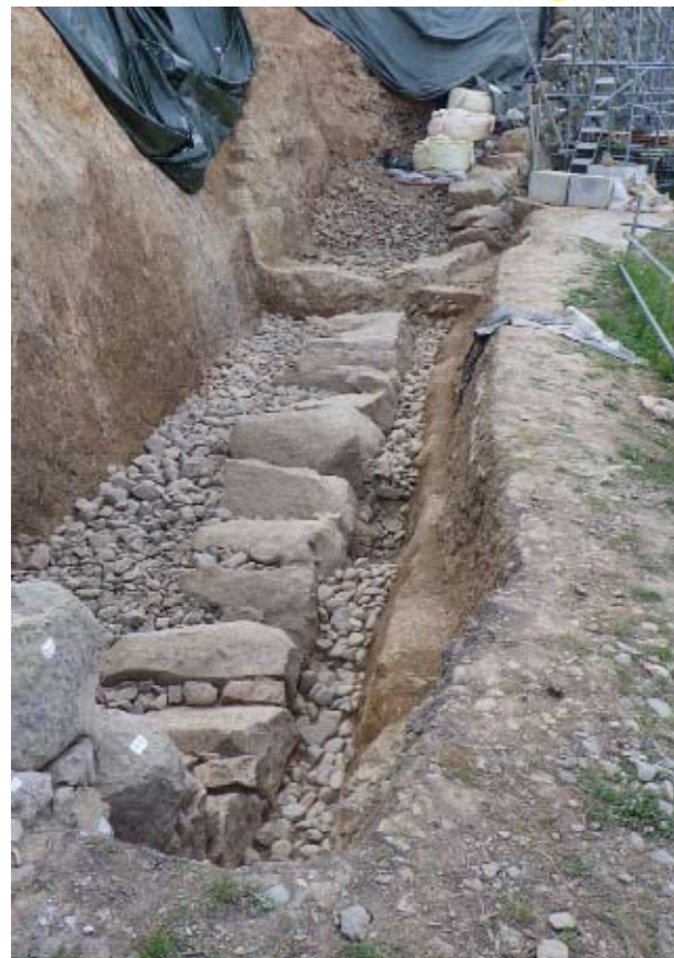
写真3 石垣の根石と掘込地業（南から）
