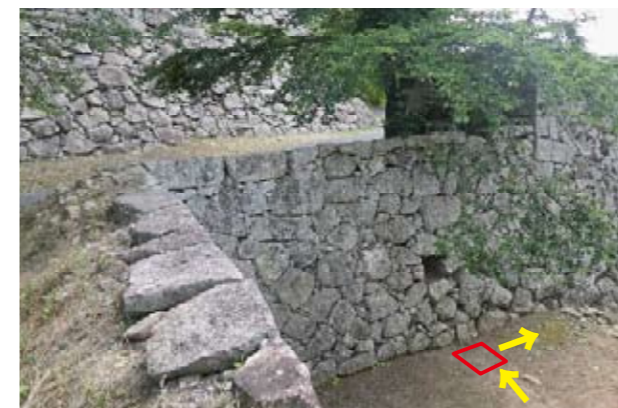
写真7 裏下門南側の排水口と枅 □が枅の位置、→が排水方向
