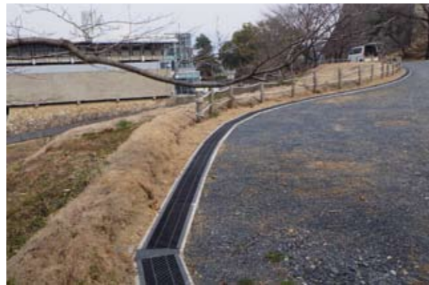
写真12 厩堀法面上に整備された排水溝（南から）
