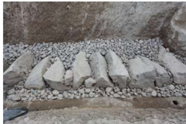
写真4 石垣の根石と掘込地業（東から）
