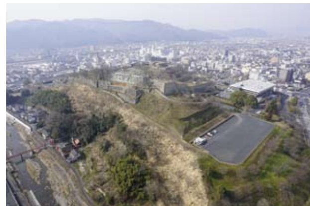
写真11 修理工事遠景（北東から）
