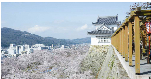
城下の道路改良工事構想を問う!
