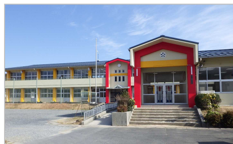
改修後の校舎
