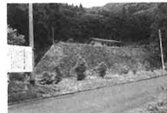
⑱ 井川発電所跡
