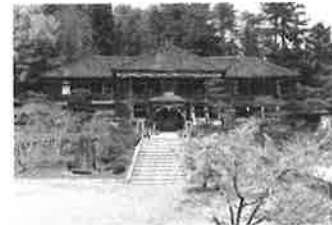
⑮ 旧吹屋小学校校舎
