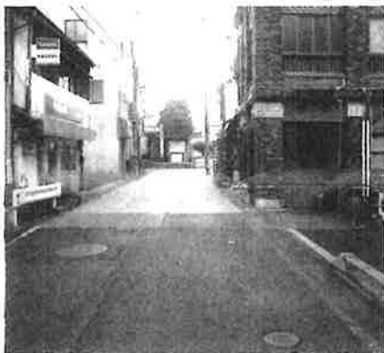
市道B80号線の拡幅付近
