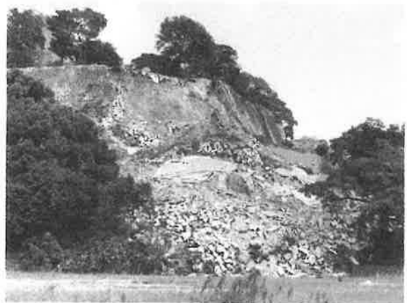
写真左が一度目の崩落 写真右が二度目の崩落
