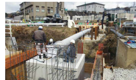
水管橋敷設工事の様子
