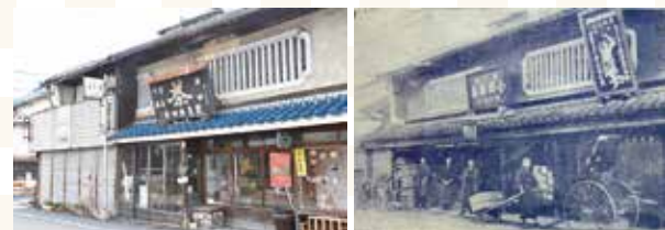
1軒の町家（写真右：大正6年頃）を昭和23年頃に改築して2軒で利用（写真左）。奥側の家の2階の覆いの後ろには、昔ながらの建屋が隠れる。
