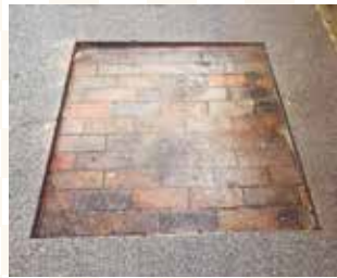
大正15年に架けられた翁橋は国の登録有形文化財。アスファルト舗装の路面の下から全国的にも珍しいレンガ舗装が見つかった。
