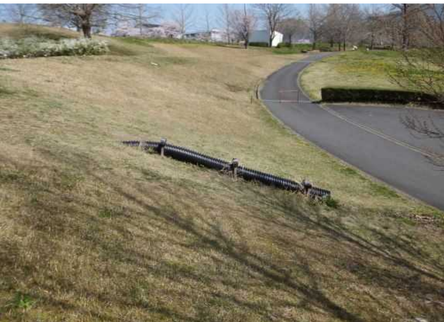
玄関前の排水側溝の出口
