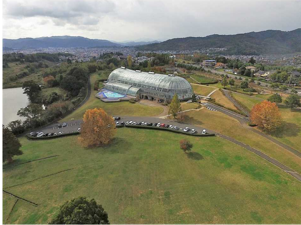
北東側より空撮(遠景)
