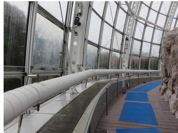
プールサイド(スロープ部)
