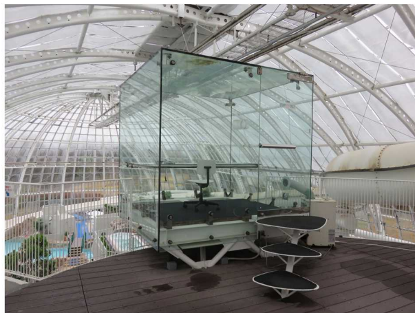
監視兼放送ルーム
