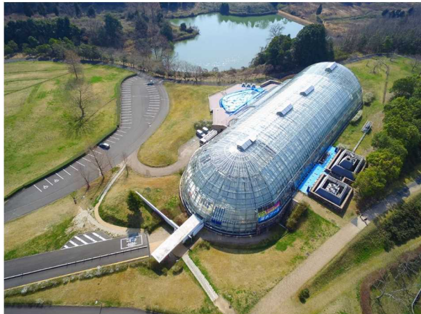
北西側より空撮(近景)
