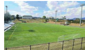
ワードシステム フィールド (津山スポーツセンター サッカー・ラグビー場)
