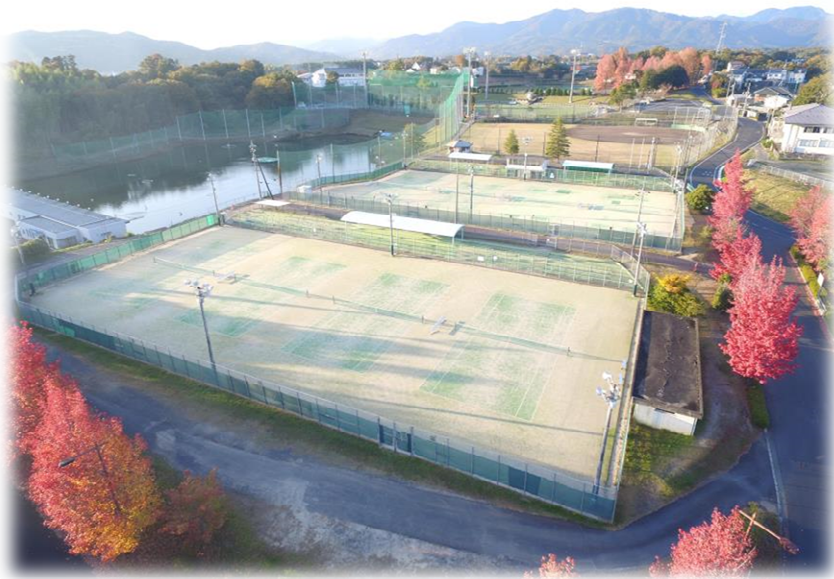
施設全体 南東より
