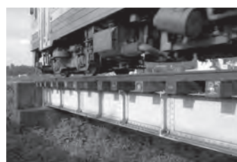
1-④ 谷川橋梁
