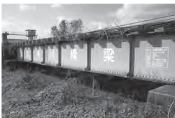
2-① 大溝川橋梁
