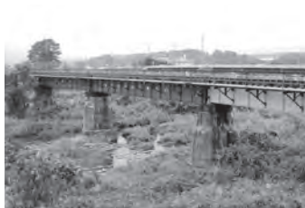
3-③ 第2吉井川橋梁
