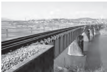
3-② 第1吉井川橋梁
