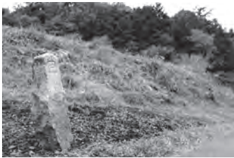
5-① 第 1 河原開渠付近
