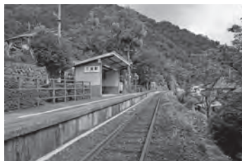
10-② プラットホーム 02
