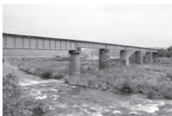
5-① 加茂川橋梁
