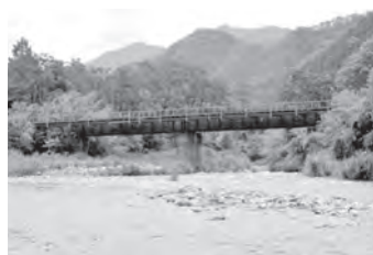
5-③ 第 2 加茂川橋梁
