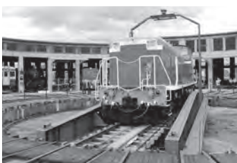
5-① 旧津山扇形機関車庫と転車台
