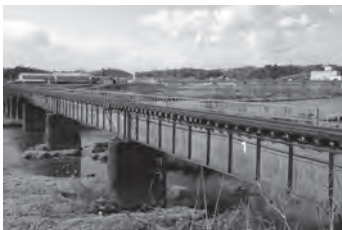
3-① 吉井川橋梁
