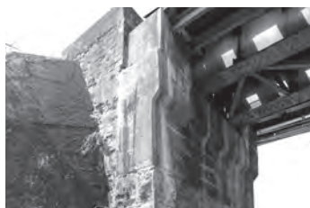
3-① 第21架道橋
