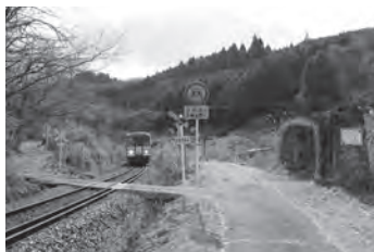
5-① 姫新線すい道西踏切付近のコンクリート構造物
