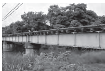
1-② 第2佐良川橋梁
