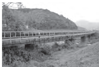
5-⑤ 第 1 加茂川橋梁
