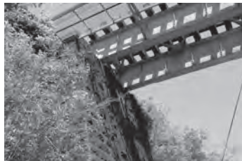
3-② 奥稗田川橋梁
