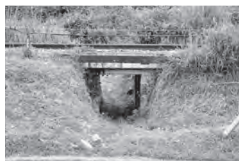
3-② 第8避溢橋
