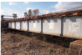
2-① 大溝川橋梁
