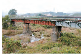
3-③ 第2吉井川橋梁
