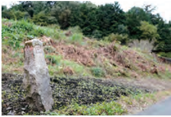
5-① 第1 河原開渠付近
