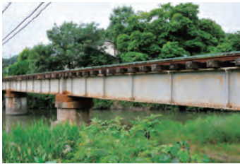
1-② 第2佐良川橋梁
