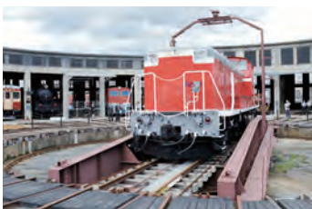
5-① 旧津山扇形機関車庫と転車台
