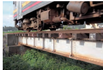
1-④ 谷川橋梁
