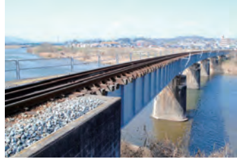
3-② 第1吉井川橋梁
