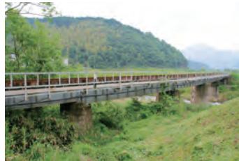
5-⑤ 第1加茂川橋梁
