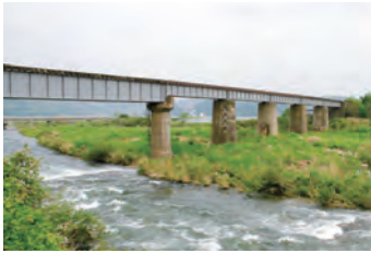
5-① 加茂川橋梁
