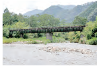
5-③ 第2加茂川橋梁
