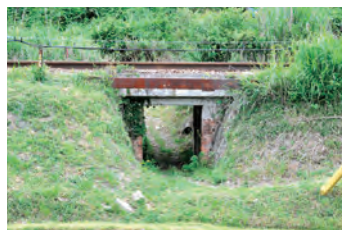
3-② 第8避溢橋
