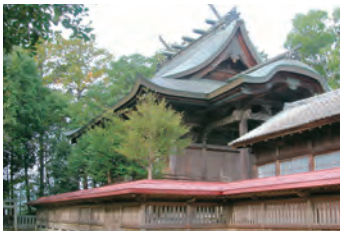
5-① 鶴山八幡宮本殿
