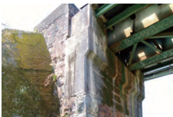
3-① 第21架道橋
