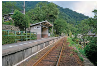
10-② プラットホーム 02
