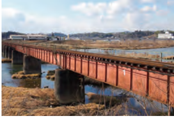
3-① 吉井川橋梁
