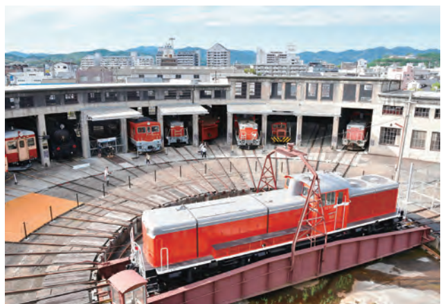
旧津山扇形機関車庫と転車台
