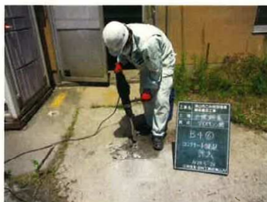
ハンマードリルによる舗装除去
