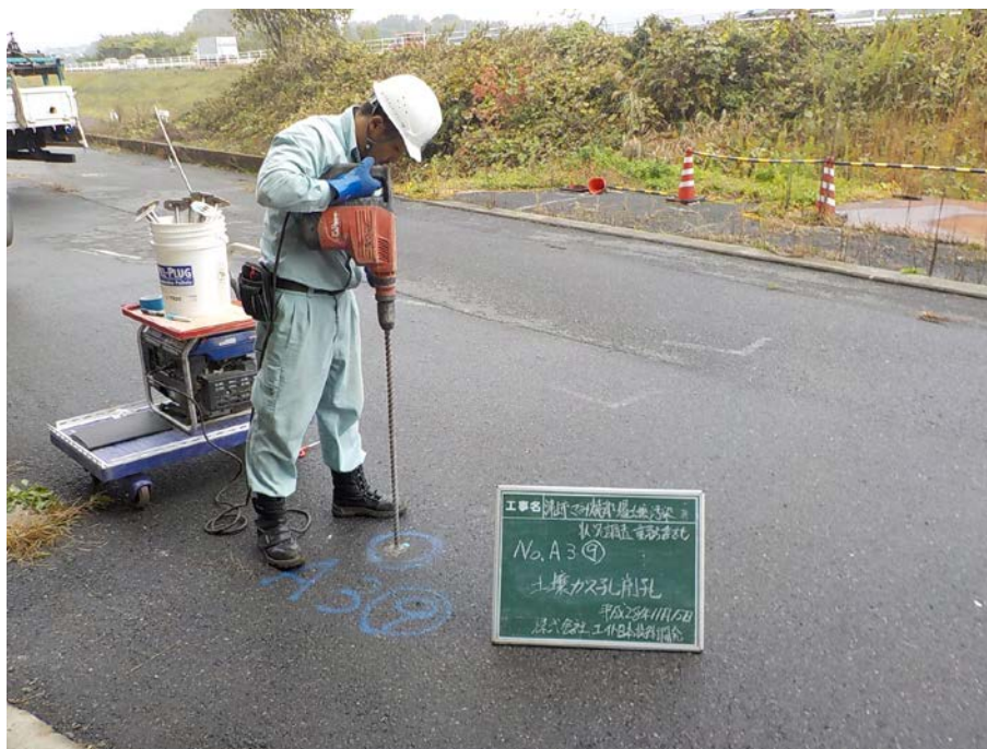
写真 3-1-1-2. ハンマードリルによる削孔
