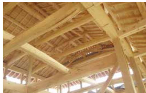
補助を受けた住宅の内部
