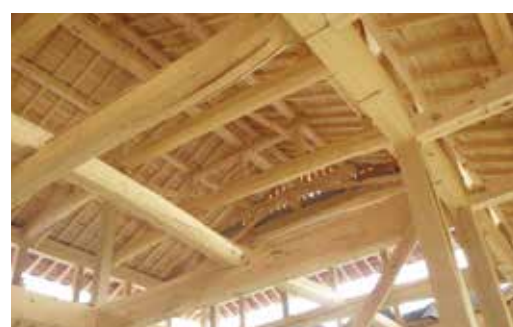
補助を受けた住宅の内部
