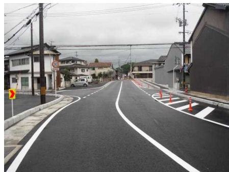
工事完成(南から)
