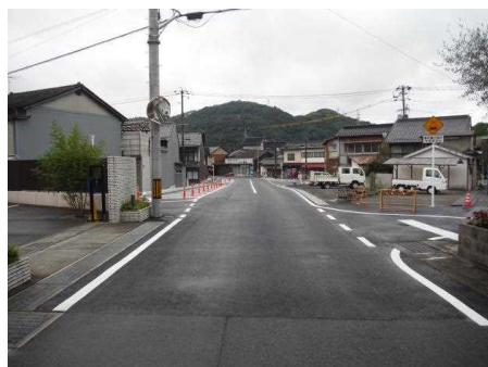
工事完成(北から)
