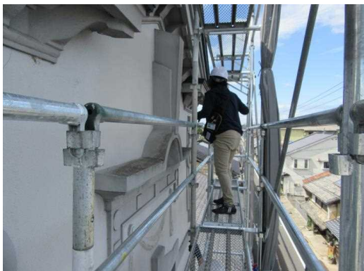
改修設計(屋根外壁調査)(令和4年度)
