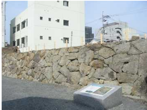
整備された京橋門跡
