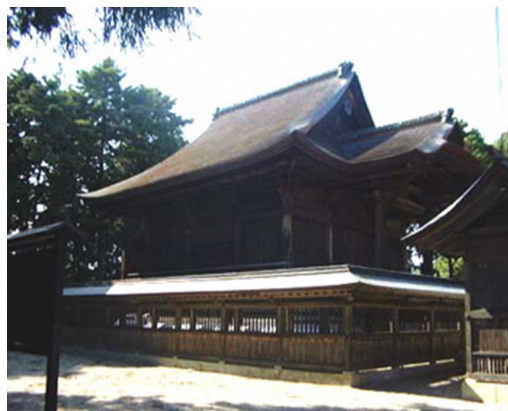
国の重要文化財 総社本殿
