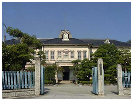
国の重要文化財 岡山県立津山高等学校本館
