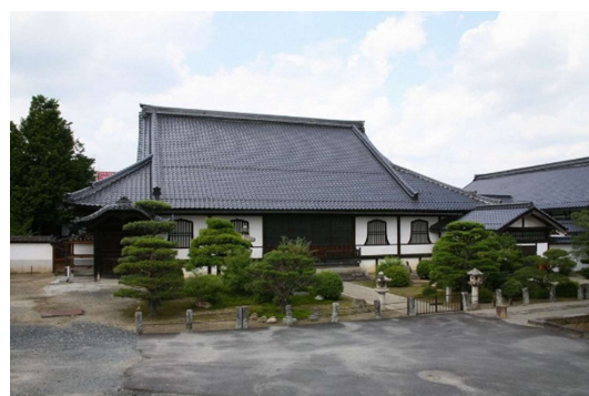
国の重要文化財 本源寺本堂
