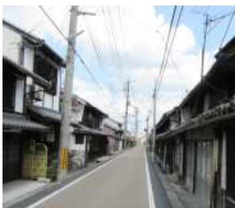
景観を阻害する電線、電柱
