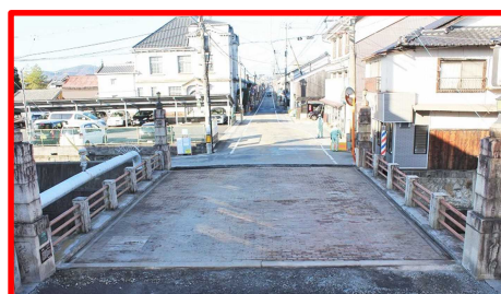
調査で現れた舗道レンガ
