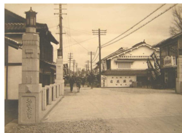
建設当初の翁橋
