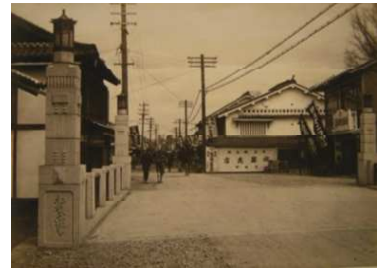
建設当初の翁橋
