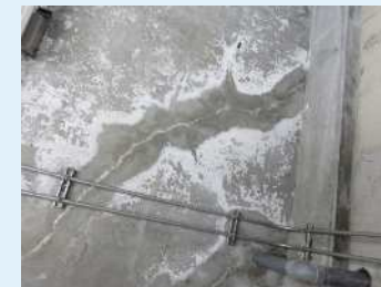
建物コンクリート劣化
