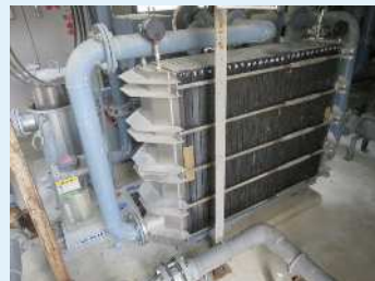
ろ過装置の劣化
