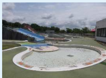
プール内塗膜の剥離
