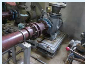
ポンプの不良
