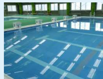
内部塗膜の剥離
