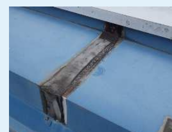
エキスパンション部の劣化
