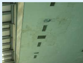
結露による天井劣化
