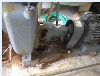
ポンプ類の劣化
