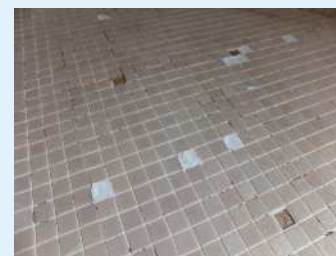
屋外造形物の劣化
