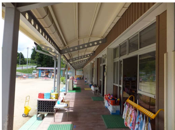
廊下 開放廊下となっています。
