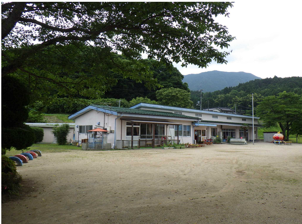
外観 山に囲まれた静かな場所に立地しています。南側に園庭が広がっています。
